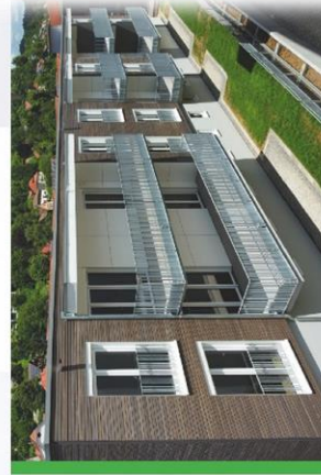
Projekt Neuffener Straße, Bad Urach
